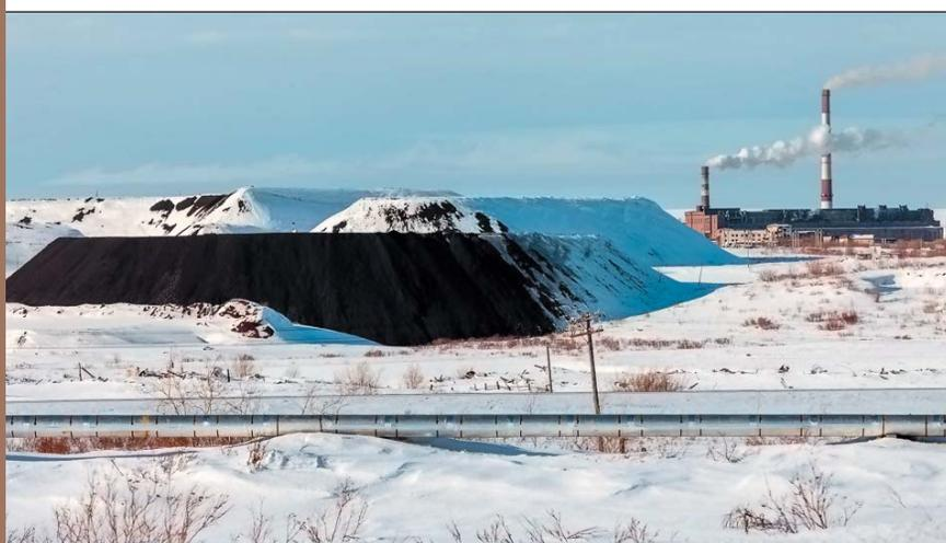
Рис.2. Отвалы горной породы одной из угольных шахт Воркуты. Высота их может достигать более 50 м.
