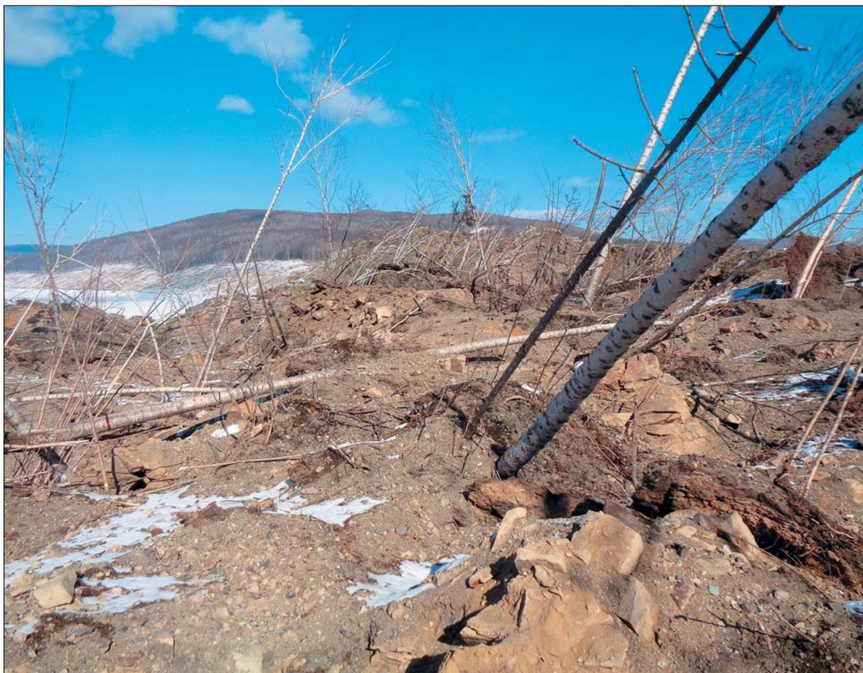
«Пьяный лес» на поверхности оползневого тела.
