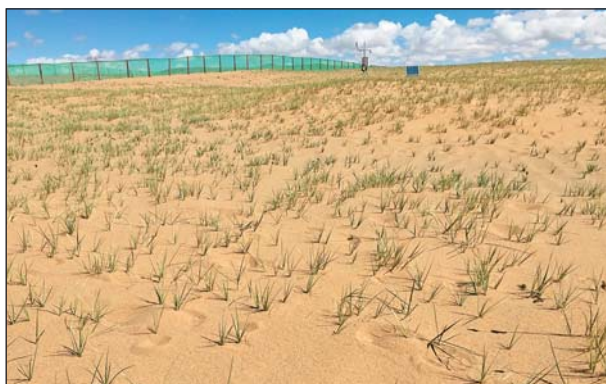
Системы противодефляционной защиты вдоль Транстибетской железной дороги на высоте 4800 м: сетчатые ограждения для захвата золотого песка и формирования искусственных дюнных массивов (вверху) и их биологическая рекультивация.
