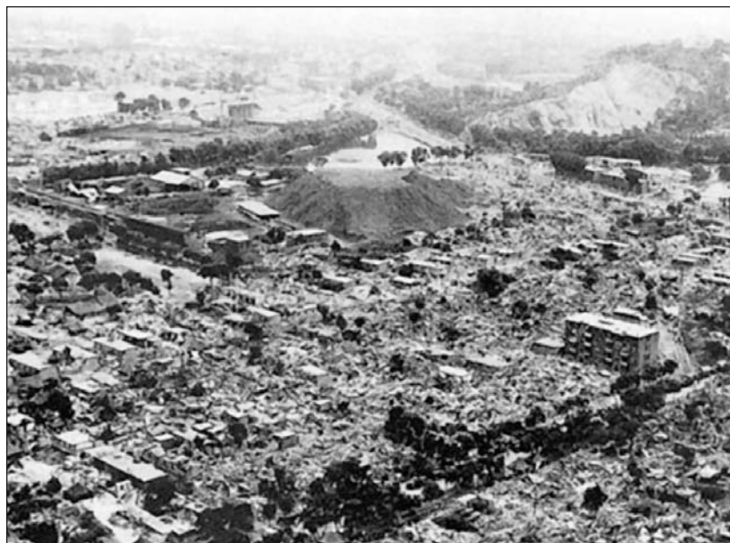
Полностью разрушенный квартал частных одноэтажных домов из необожженного кирпича. Фото с самолета (снимок из фильма Р.Кармена, 1949 г.).
