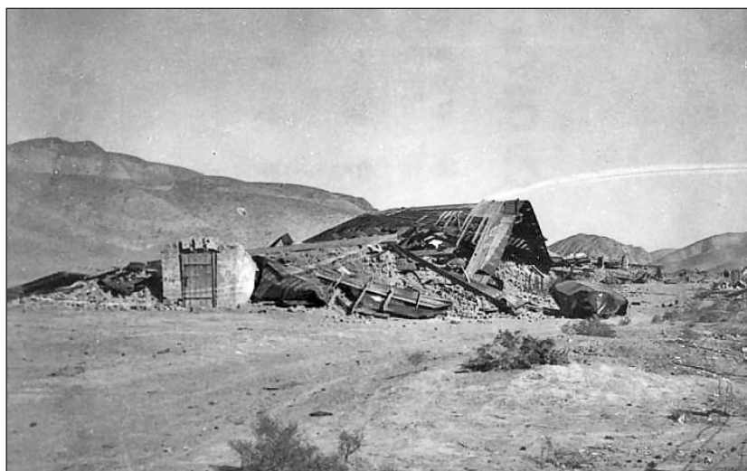
Разрушения в поселке Куру-Гандан, (к юго-востоку от Ашхабада) соответствуют интенсивности землетрясения X баллов.
