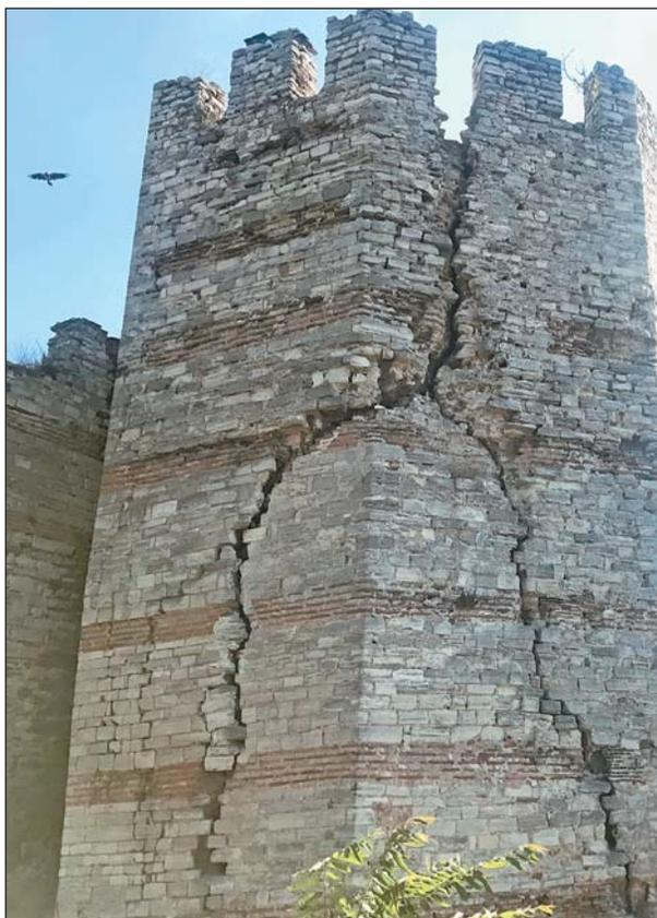
Рис.7. Башни древней стены Феодосия в Стамбуле с антисейсмическими поясами и со следами обрушения и растрескивания за счет сильного ( $\geq$ VIII баллов) землетрясения. Снимок 2018 г.
