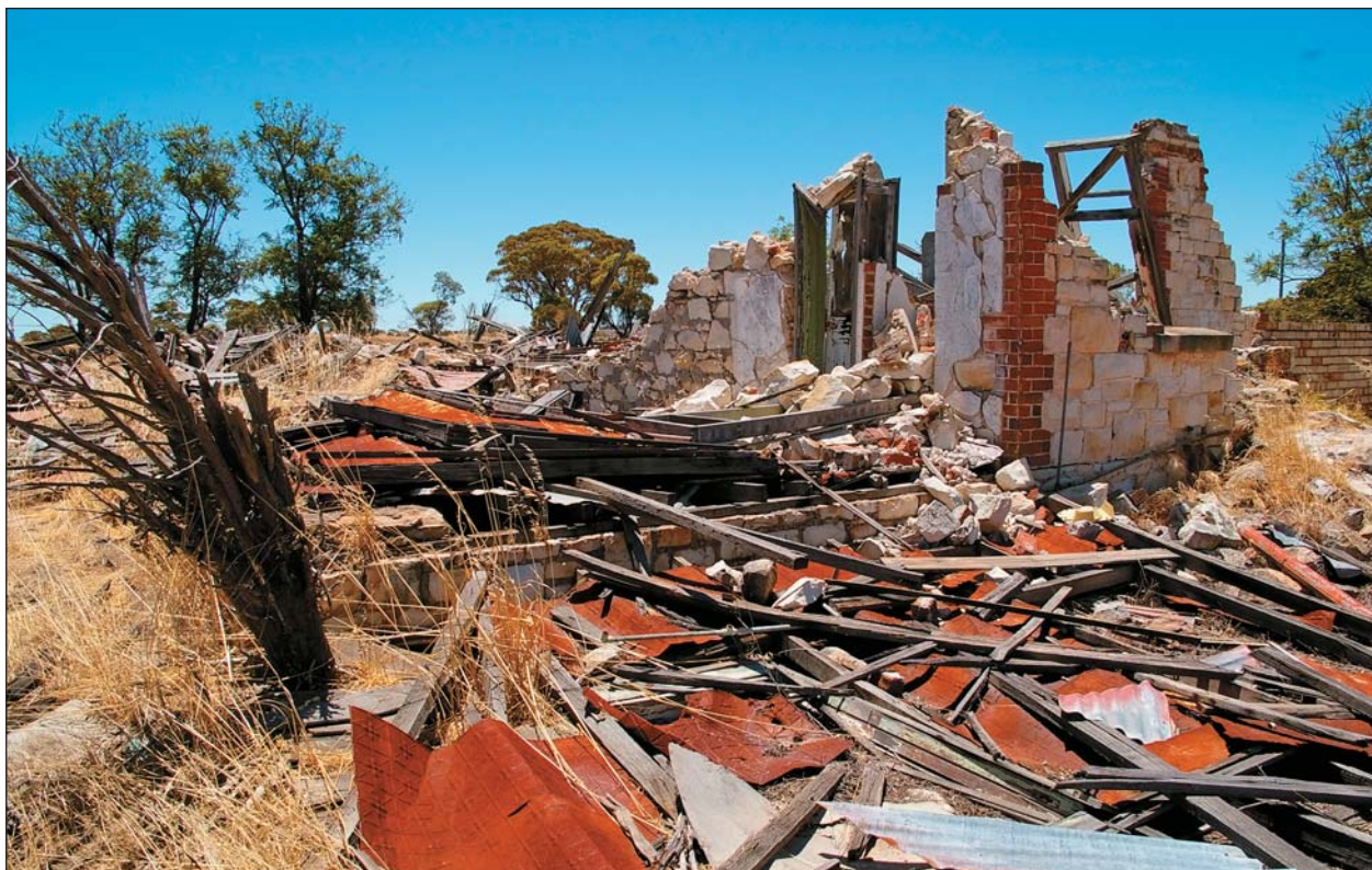
Рис.5. Катастрофическое разрушение жилого дома в Мекеринге.
