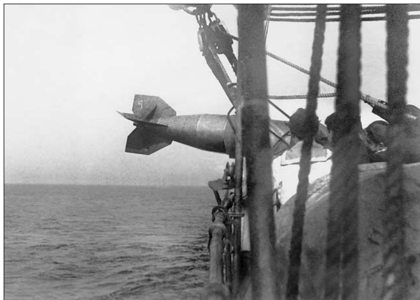
Первая выгрузка за корму гондолы с магнитометром для проведения магнитной съемки. Северная Атлантика. 1962 г.
